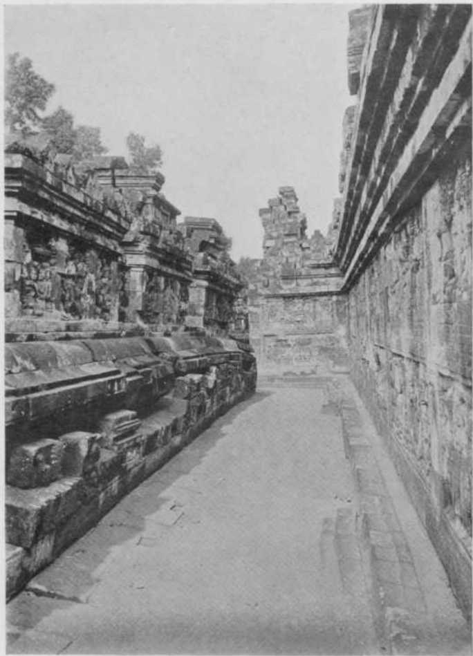
AFB. 7 Gaanderij vóór de restauratie (p. 32, 46 en 49)
